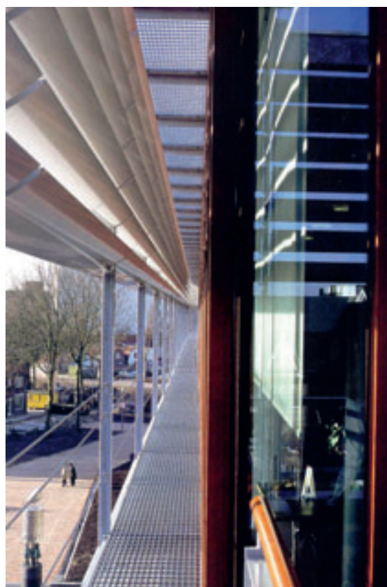
1. Dubbele façade met zonwering.
